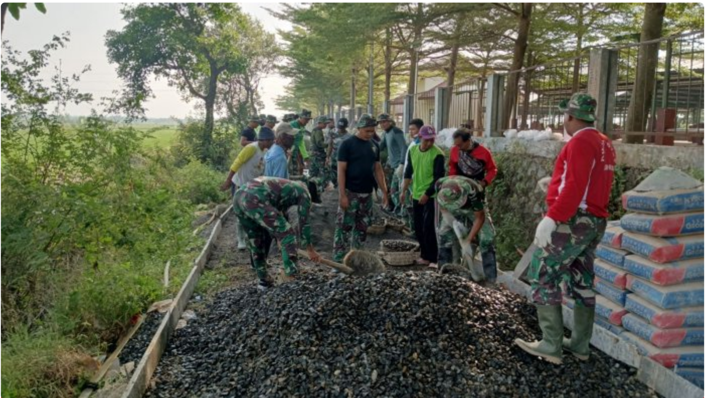
Foto istimewa ( Satgas tmmd reg 116 kebut pengecoran jalan
