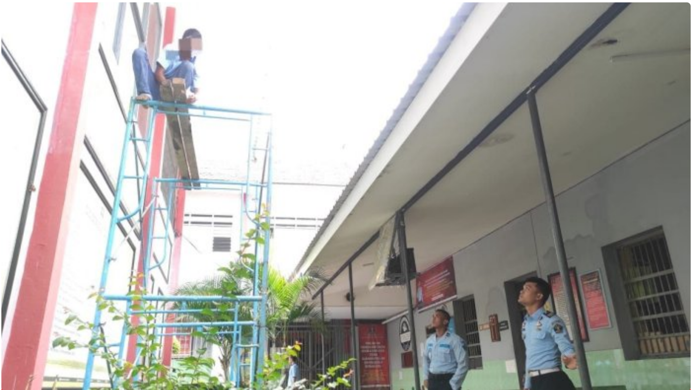
Petugas mengawasi pemeliharaan bangunan
