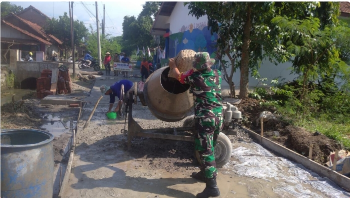
(Foto Istimewa) Pengecoran Jalan Di Dukuh Kepyar
